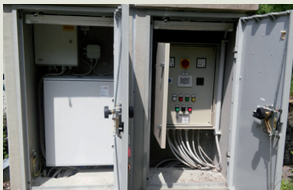
Sito periferico 565 con quadro di controllo
