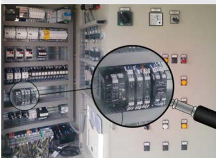
Панель для контроля и управления переездов с аппаратным обеспечением SENECA и электромеханическим дублированием
