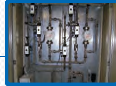
Impianto stirring per il controllo della portata dei gas tecnici (Romania)
