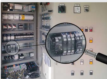
Kontroll- und Steuertafel für Unterführungen mit SENECA-Hardware und elektromechanischen Redundanzen
