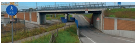
Telecontrollo sottopassi rete stradale e ferroviaria
