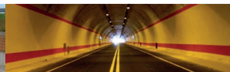
Sistema di supervisione impianto di illuminazione in galleria
