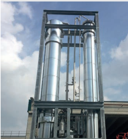
Unità di Upgrading GM-GreenMethane da 125 Smc/h biometano
