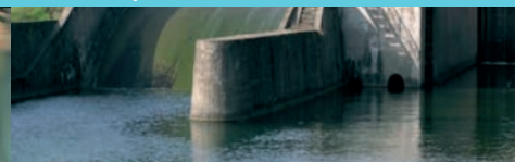
Sistema di acquisizione misure di livello e calcolo delle portate
