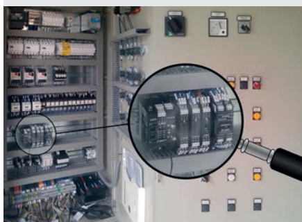
Quadro di controllo e comando per sottopassi con hardware SENECA e ridondanze elettromeccaniche
