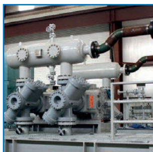
BOMBAS Y MOTORES SALAS DE PRUEBAS
